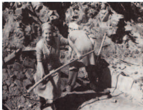
Beseitigung der Kriegstrümmer bei einem Arbeitseinsatz
