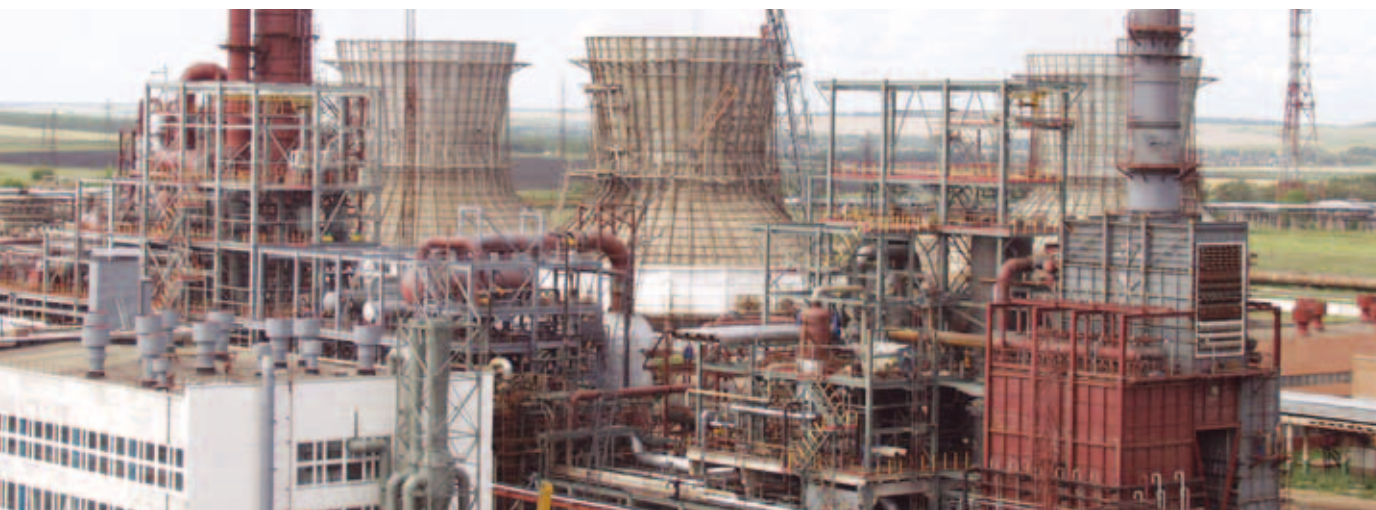
Ethylbenzol-Styrol-Anlage in Salawat während der Montagearbeiten
