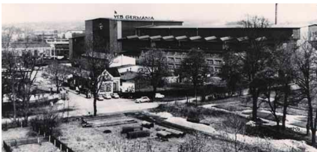
Das Firmengelände nach der ersten Rekonstruktion (1949 - 1952) mit Großbehälterhalle und Hochdruckhalle
