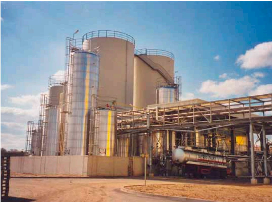
Biodieselanlage in Malchin
