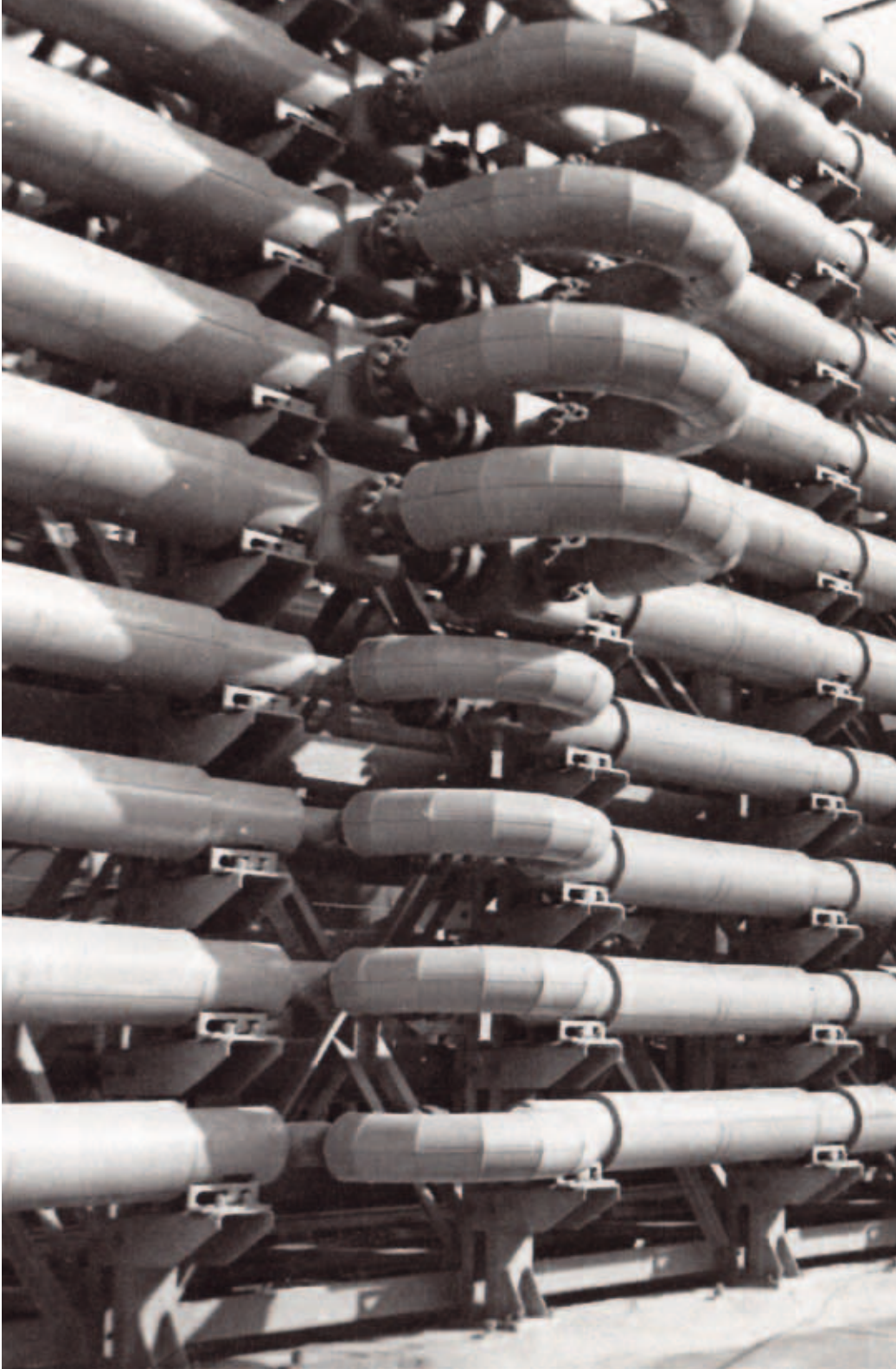
Die LDPE-Anlage Polymir 60 für den VEB Leuna Werke, 5. Straße
