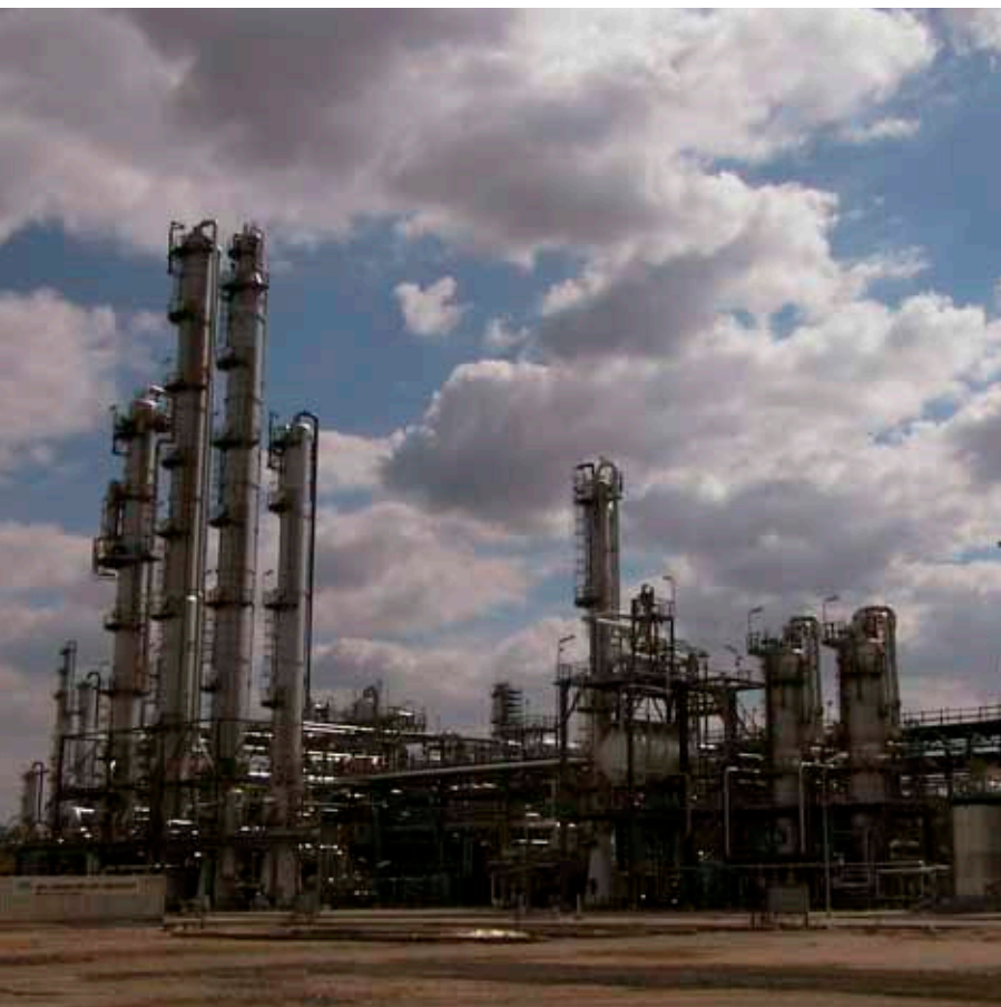
Gesamtansicht der Anlage für Butadienextraktion in Böhlen
