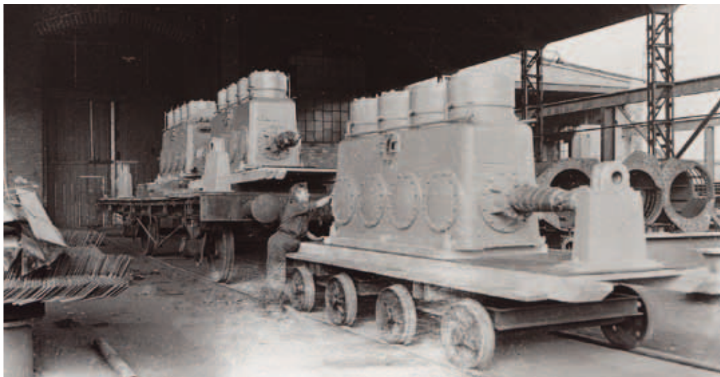
Kompressoren, stehende Verdichter
