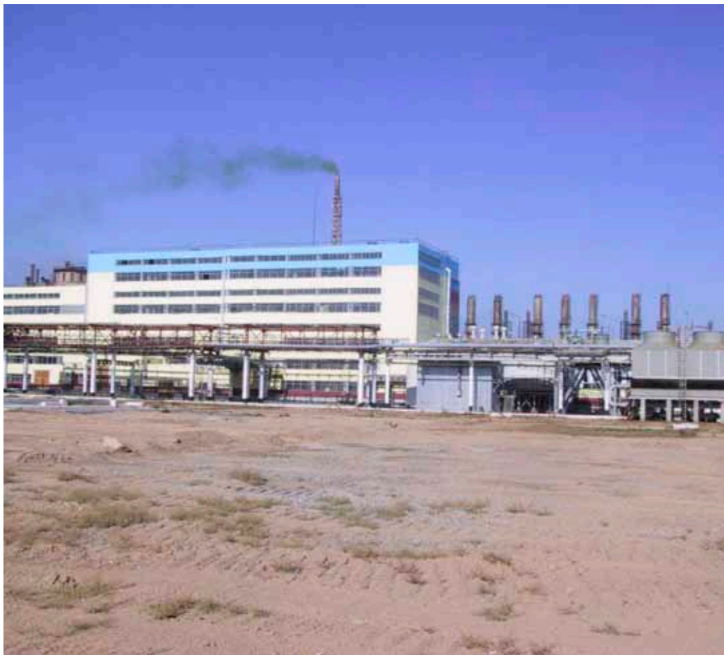
Chlorelektrolyseanlage in Navoi/Usbekistan
