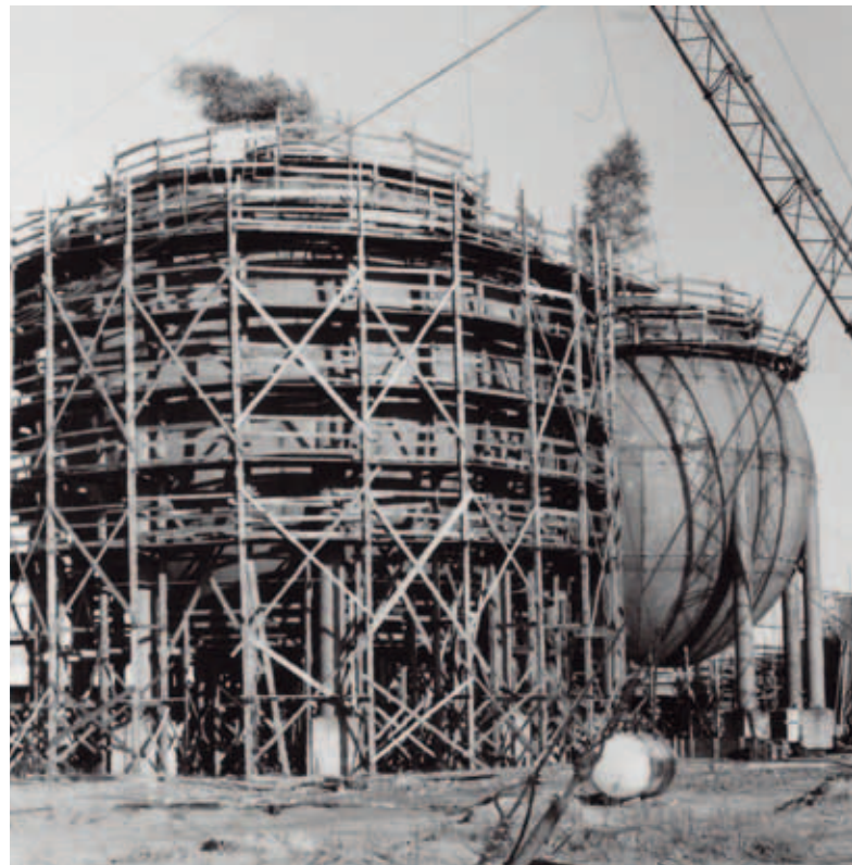
Die Ammoniakanlage aus England mit Kugelbehältern des Ammoniaklagers
