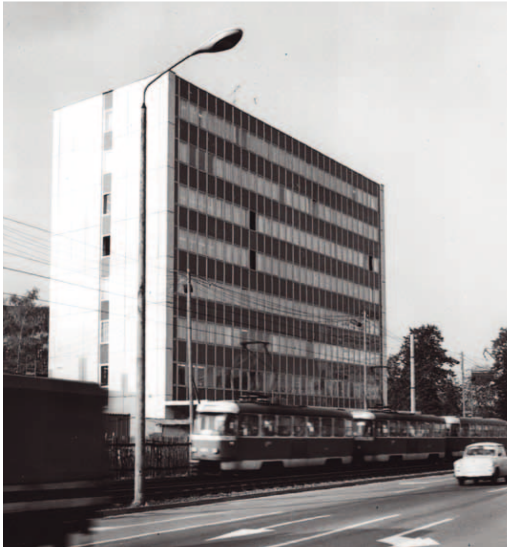
Das neue Gebäude, bezugsfertig am 1. Oktober 1980
