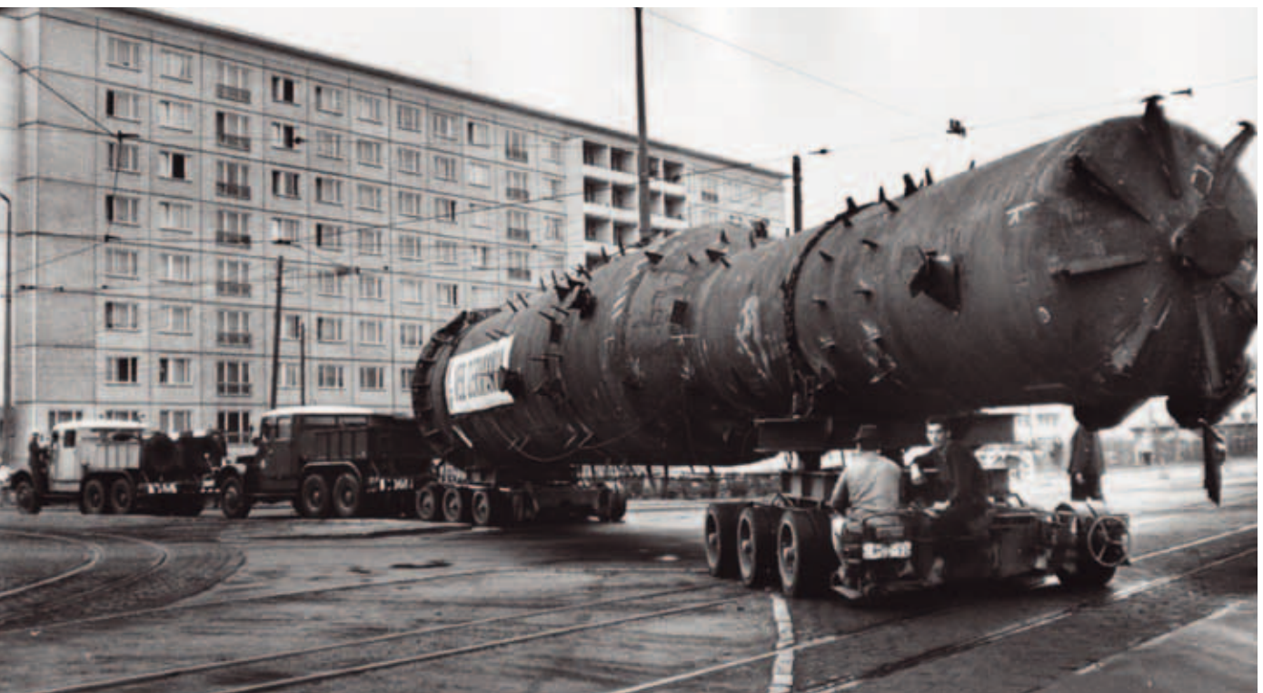
Öldruckvergasung Leuna I: Entfeuchter auf dem Straßentransport
