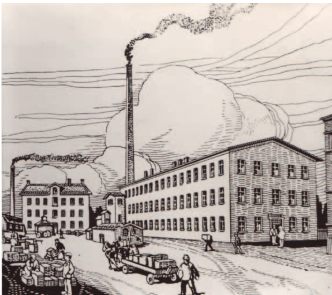
Die Fabrik in der Angerstraße im Jahr 1846
