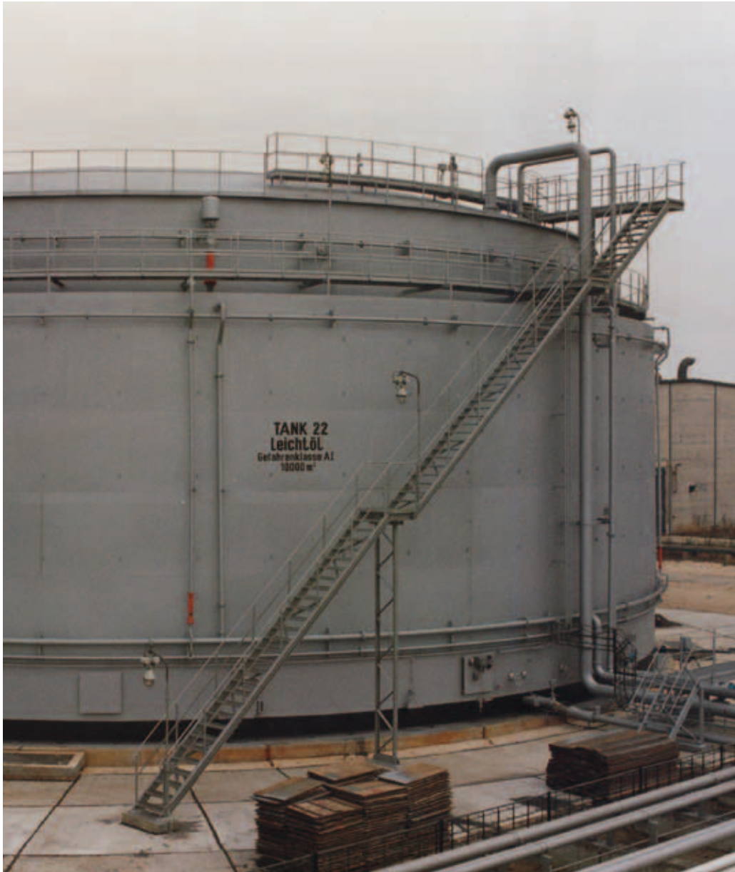
Leichtöltanklager für die Energiewerke Schwarze Pumpe
