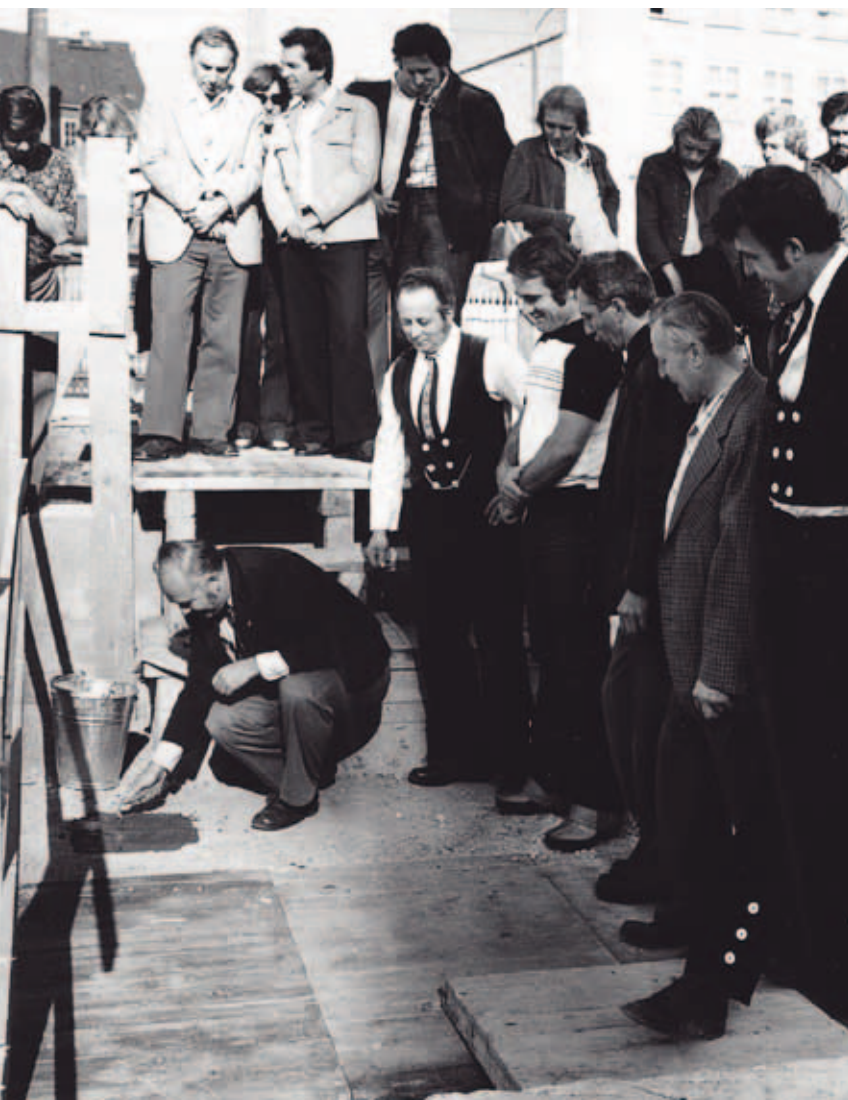
1979: Grundsteinlegung für das Projektierungsgebäude im Chemnitzer Stadtzentrum
