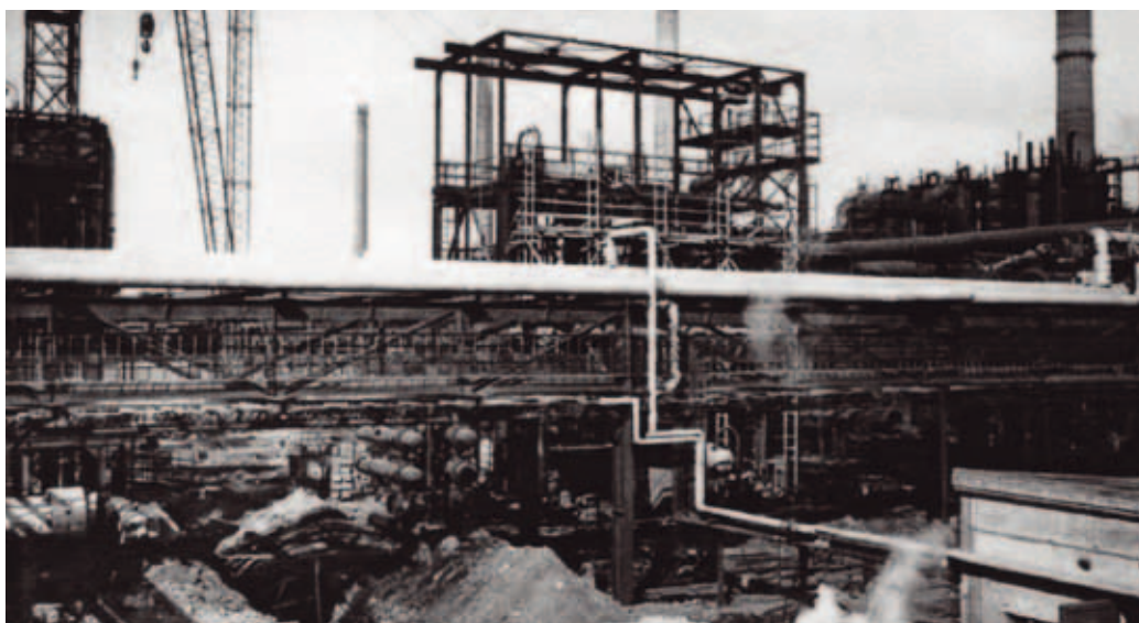
Öldruckvergasungsanlage in Leuna I
