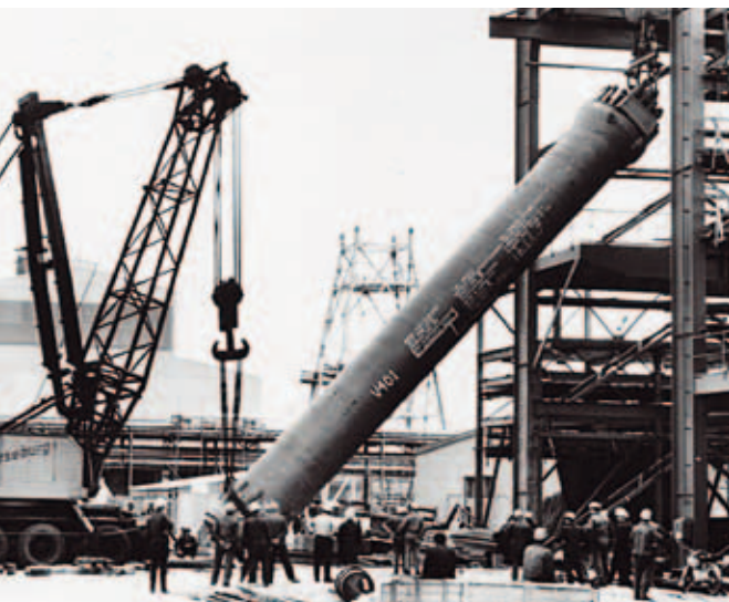
Düngemittelkomplex in Schwedt: Montage des Reaktors...
