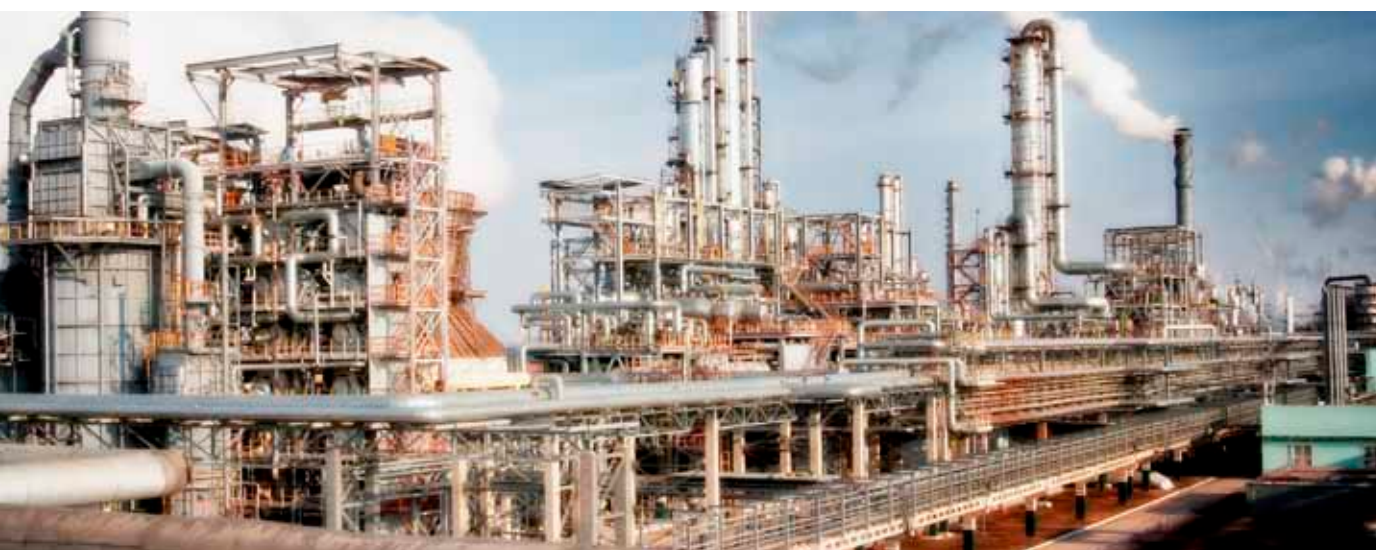
Die Ethylbenzol-Styrol-Anlage in Salawat
