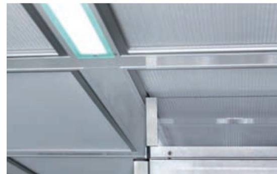
Reinraumdecke im Abfüllraum mit Filter-Fan-Units, flächenbündiger Beleuchtung und Verschützung der Abfüllmaschine
