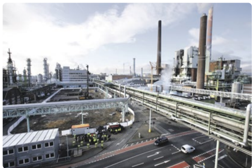
Im Nordteil des Industrieparks Höchst entstehen die neuen Gasturbinenanlagen.
