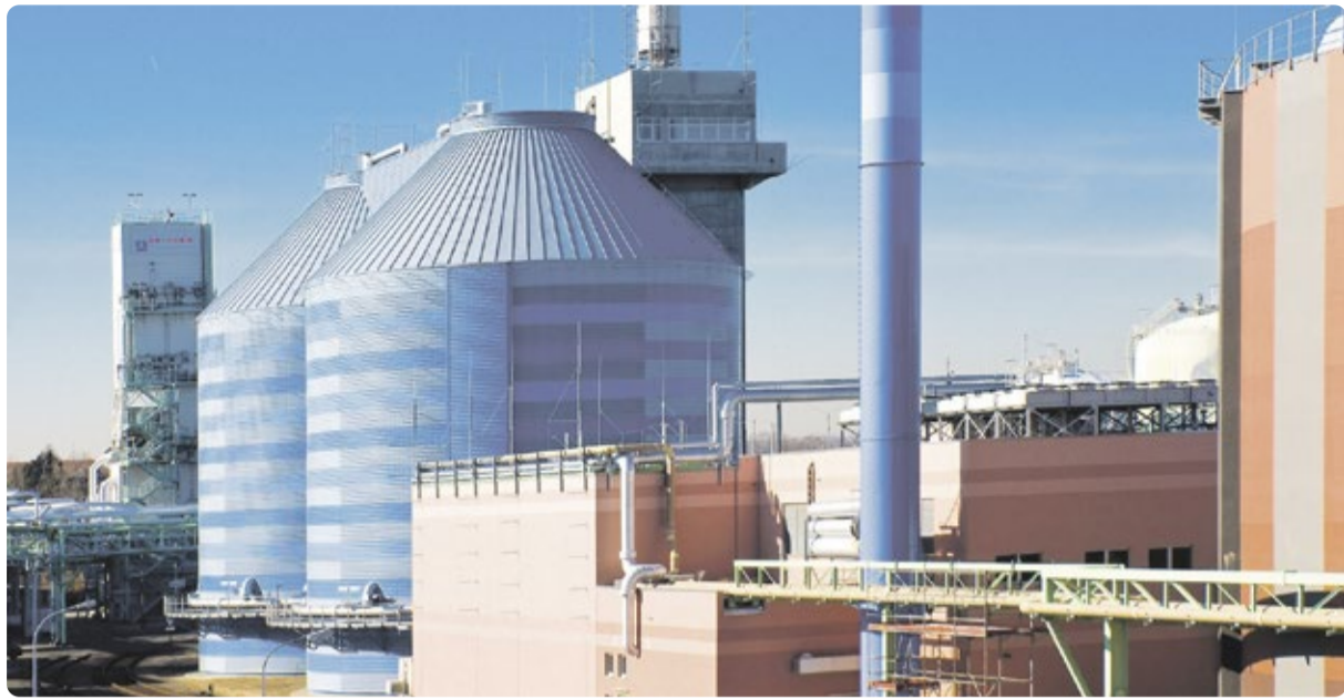
Infraser Höchst betreibt im Industriepark eine große Biogasanlage in der Klärschlämme und organische Abfälle in Biogas umgewandelt werden.
