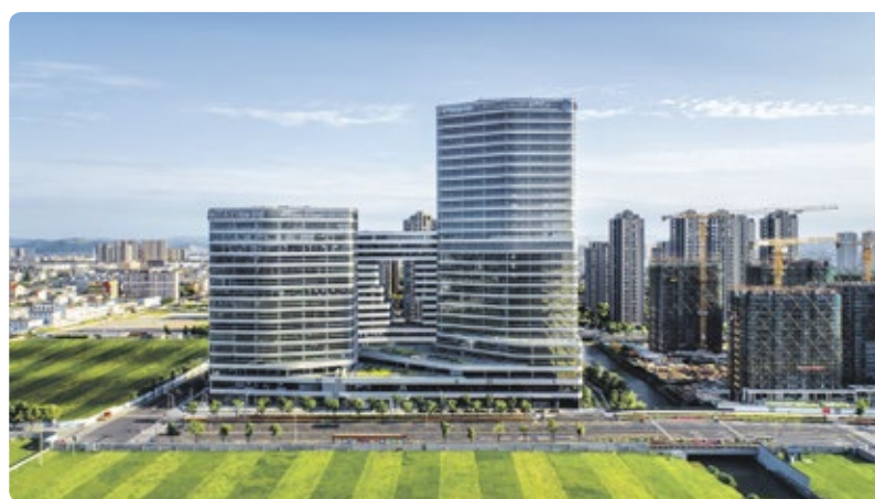
Die neuen Forschungs- und Entwicklungslabore im 17. und 18. Stock des Gebäudekomplexes in Ningbo konnten 2019 bezogen werden und umfassen nach der Erweiterung eine Gesamtfläche von 3.000 m 2 .
