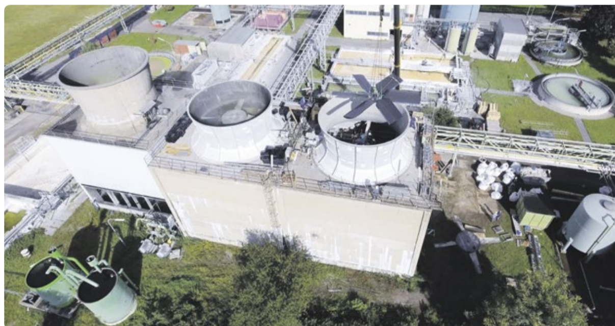
Xervon betreibt wie hier in Köln Kühltürme, die gekühltes Wasser für Kunden aus dem Bereich der Prozessindustrie bereitstellen und regelmäßig gewartet werden müssen.
