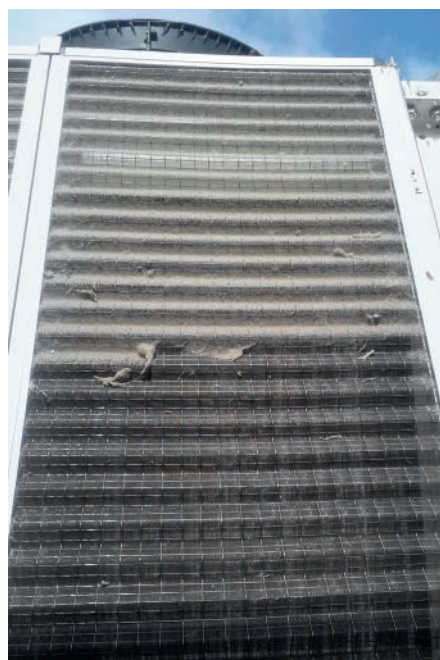
Abb. 2: Moderne Edelstahlfilter weisen auch verschmutzt nur einen minimalen Druckverlust auf.
