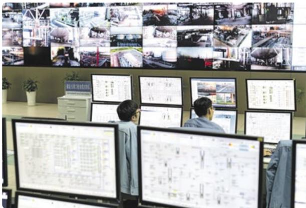
Mehrere hundert Anlagenfahrer überwachen die Raffinerie und ihre Teilanlagen nicht nur mithilfe des Prozessleitsystems Simatic PCS 7, sondern auch mittels eines großflächigen digitalen Videoüberwachungssystems.
