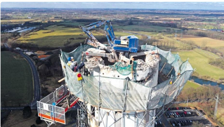
Neben der visuellen Inspektion von Anlagen, schwer zugänglichen Außenbereichen, Fackeln oder Dächern lassen sich Industriedrohnen auch zur Unterstützung von Abrissarbeiten in luftiger Höhe wie hier am Evonik-Standort Marl einsetzen.
