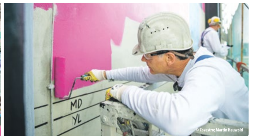
Mit 2.000 bar Wasserdruck wurde die alte Beschichtung bis auf den Betongrund abgetragen. Dann zeichnete Künstler Martin Heuwold die Bauklotz-Motive an das Gebäude an, die anschließend Schritt für Schritt in den sechs Covestro-Farben und Farbschattierungen ausgemalt wurden.
