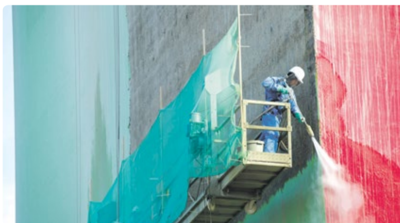
Mit 2.000 bar Wasserdruck wurde die alte Beschichtung bis auf den Betongrund abgetragen. Dann zeichnete Künstler Martin Heuwold die Bauklotz-Motive an das Gebäude an, die anschließend Schritt für Schritt in den sechs Covestro-Farben und Farbschattierungen ausgemalt wurden.
