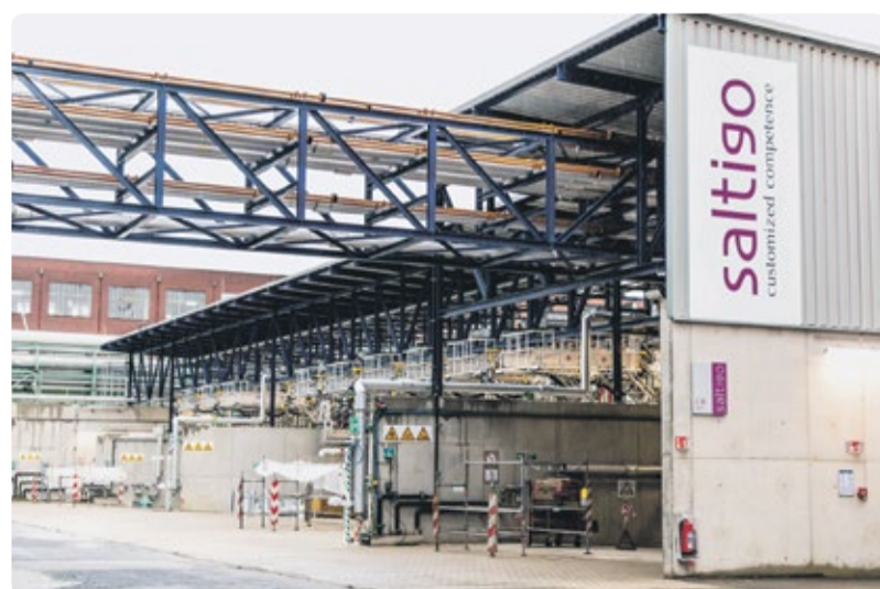
Das aktive Tankcontainerlager mit Rohrbrücke stellt eine effiziente Rohstoff- und Lösungsmittelversorgung der Produktion im ZeTO und den benachbarten Produktionsbetrieben sicher.
