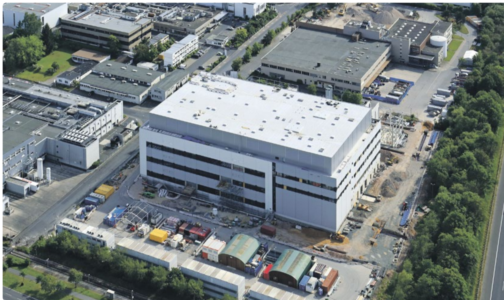
Komplexer Bau entsteht: Neben der Produktion wird es im neuen Biotest-Gebäude auch Büro-, Labor- und Lagerbereiche geben.
