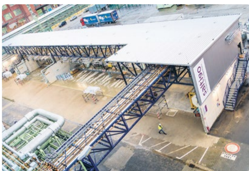
Das aktive Containerlager stellt eine effiziente Rohstoff- und Lösungsmittelversorgung der Produktion im ZeTO und der angrenzenden Plant 4 sicher. ISO-Tankcontainer können mittels eines Rohrbahnwegs direkt mit den Produktionsanlagen verbunden werden.
