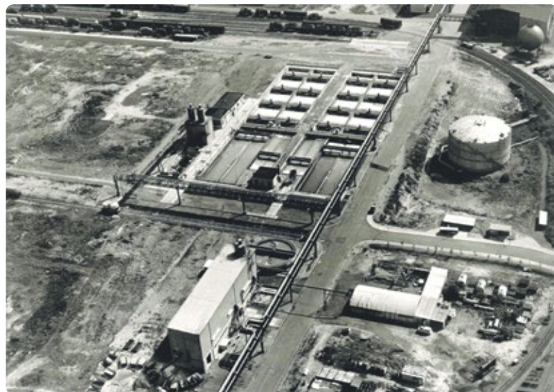
Vor 50 Jahren: Die Abwasserreinigungsanlage der ehemaligen Hoechst AG im heutigen Industriepark Höchst nach ihrer Inbetriebnahme.
