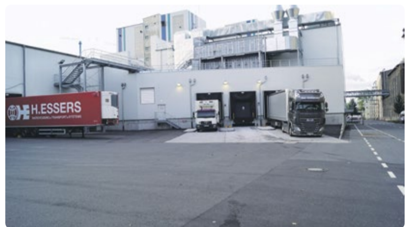
Erweiterung des Sterigenics-Gebäudes im Industriepark Kalle-Albert in Wiesbaden.
