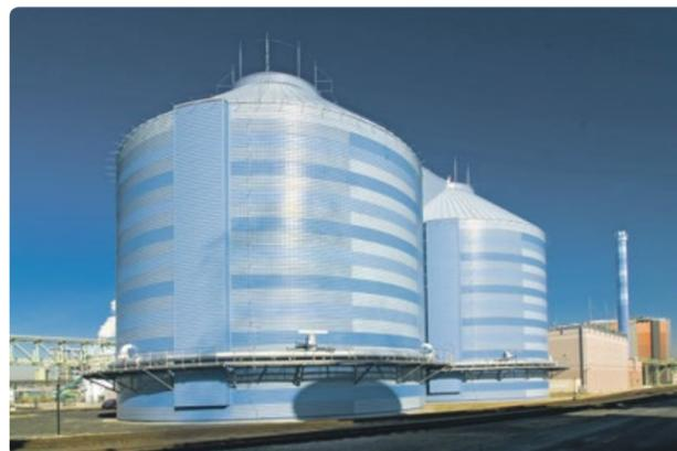
In den zwei 30 m hohen Fermentern der Biogasanlage erzeugt Infracore Höchst umweltfreundliche Energie aus Klärschlamm und organischen Abfällen.
