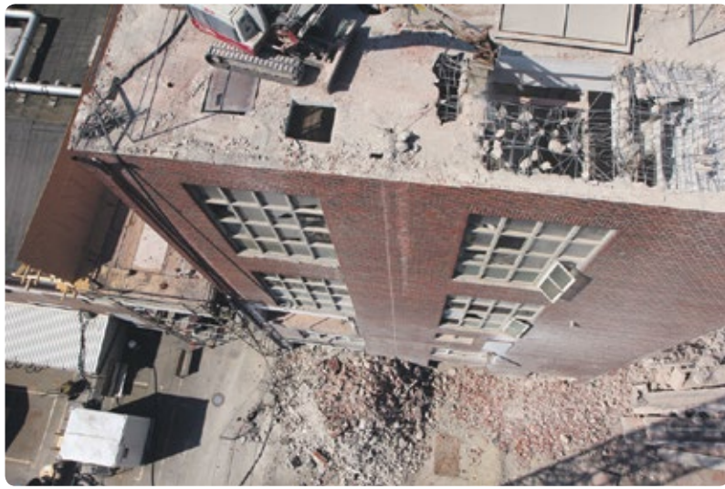
Abriß für den Fortschritt: Im Chemiapark Gendorf entsteht eine neue Messwarte für das Kraftwerk. Dafür musste ein altes, ungenutztes Mischhaus weichen.
