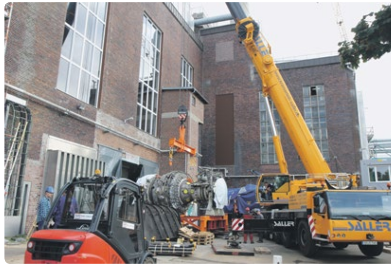
Auch die Gasturbine als Herzstück des KWK-Kraftwerks wird erneuert.
