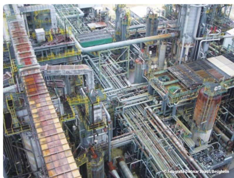
140 km oberirdische und 20 km unterirdisch verlaufende Rohrleitungen mussten rückgebaut werden.
