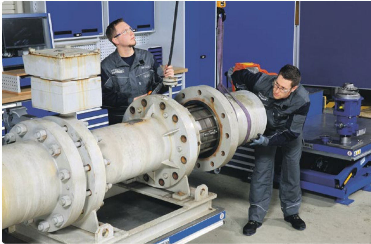
Instandhaltungsspezialisten beim Montieren einer Spaltröhre.
