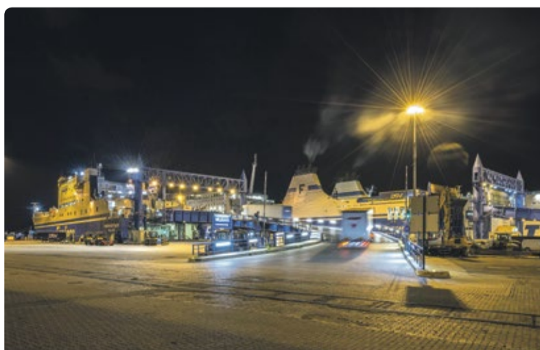
Nach Abschluss der Arbeiten werden 330 Leuchten auf 63 Masten den Skandinavienkai erhellen.
