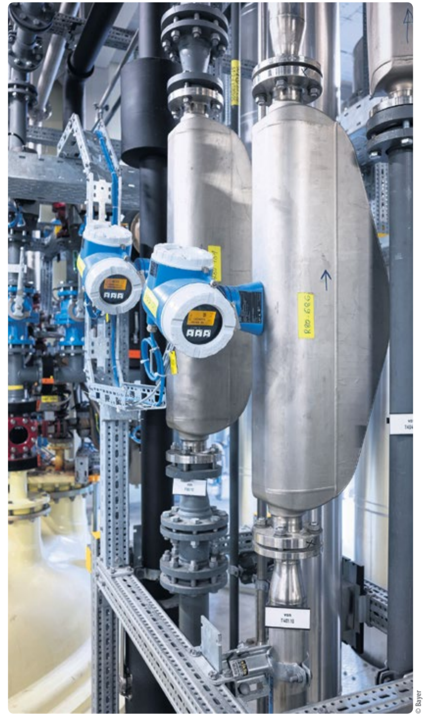
Durchfluss-Messgeräte in der neuen Produktionsanlage von Bayer CropScience in Muttenz.
