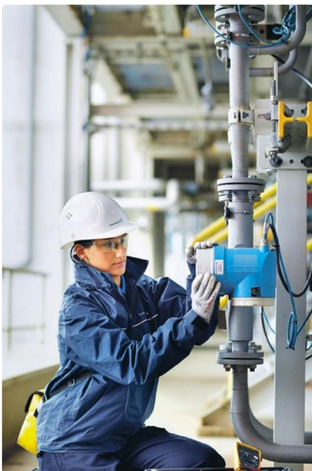
Die SIL-Sequenz in den Zweileiterngeräten für Durchfluss und Füllstand garantiert eine fehlerfreie Geräteeinstellung und eine sichere Funktion der Schutzeinrichtung.
