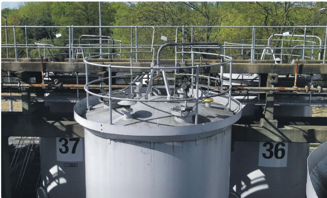
PPG Industries, einer der führenden Hersteller von Autolacken, verfügt jetzt mit dem Radar Messumformer Sitrans LR250 über eine kontinuierliche Füllstandmessung auf den Prozessbehältern.
