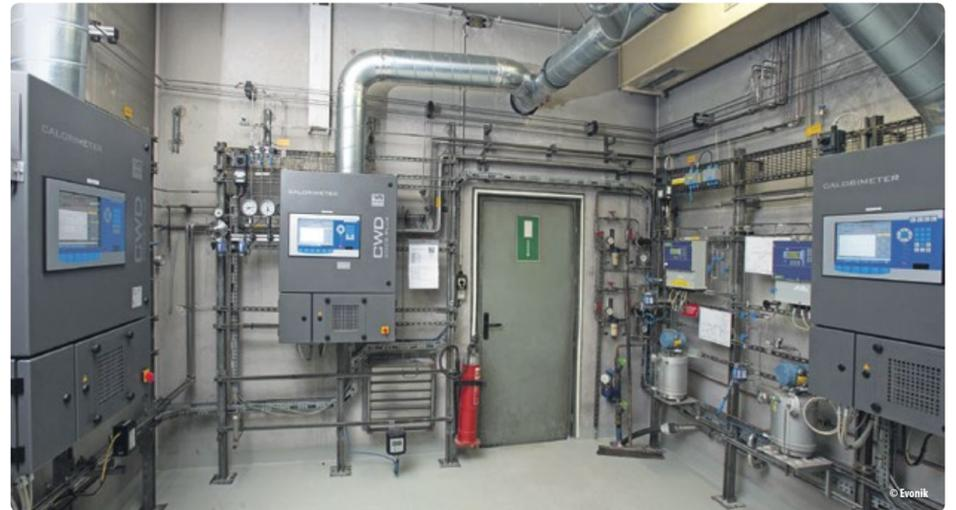
In der Kalorimeter-Messstation am Standort Marl wird der Brennwert der anfallenden Prozessgase mit Hilfe von drei Kalorimetern bestimmt
