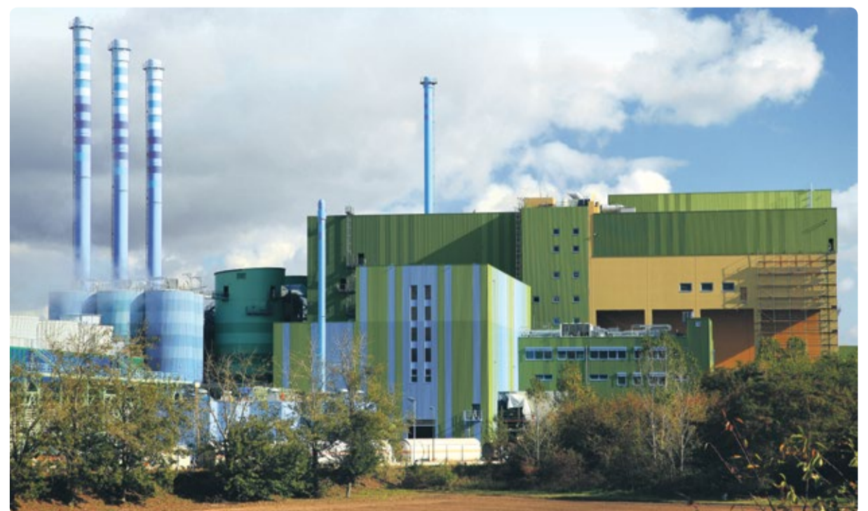
Die Ersatzbrennstoff-Anlage arbeitet nach dem Prinzip der Kraft-Wärme-Kopplung und ermöglicht nachhaltige Energieerzeugung. Zu den drei Verbrennungsstraßen der Anlage gehören drei etwa 80 m hohe Schornsteine und jeweils eine eigene Rauchgasreinigung.
