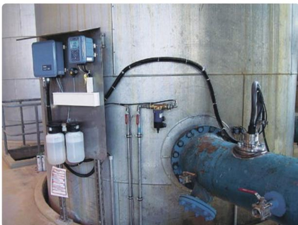
Vollautomatische pH-Messstelle bestehend aus Ceramat WA 150, Unical 9000 C und Portos 3400 C
