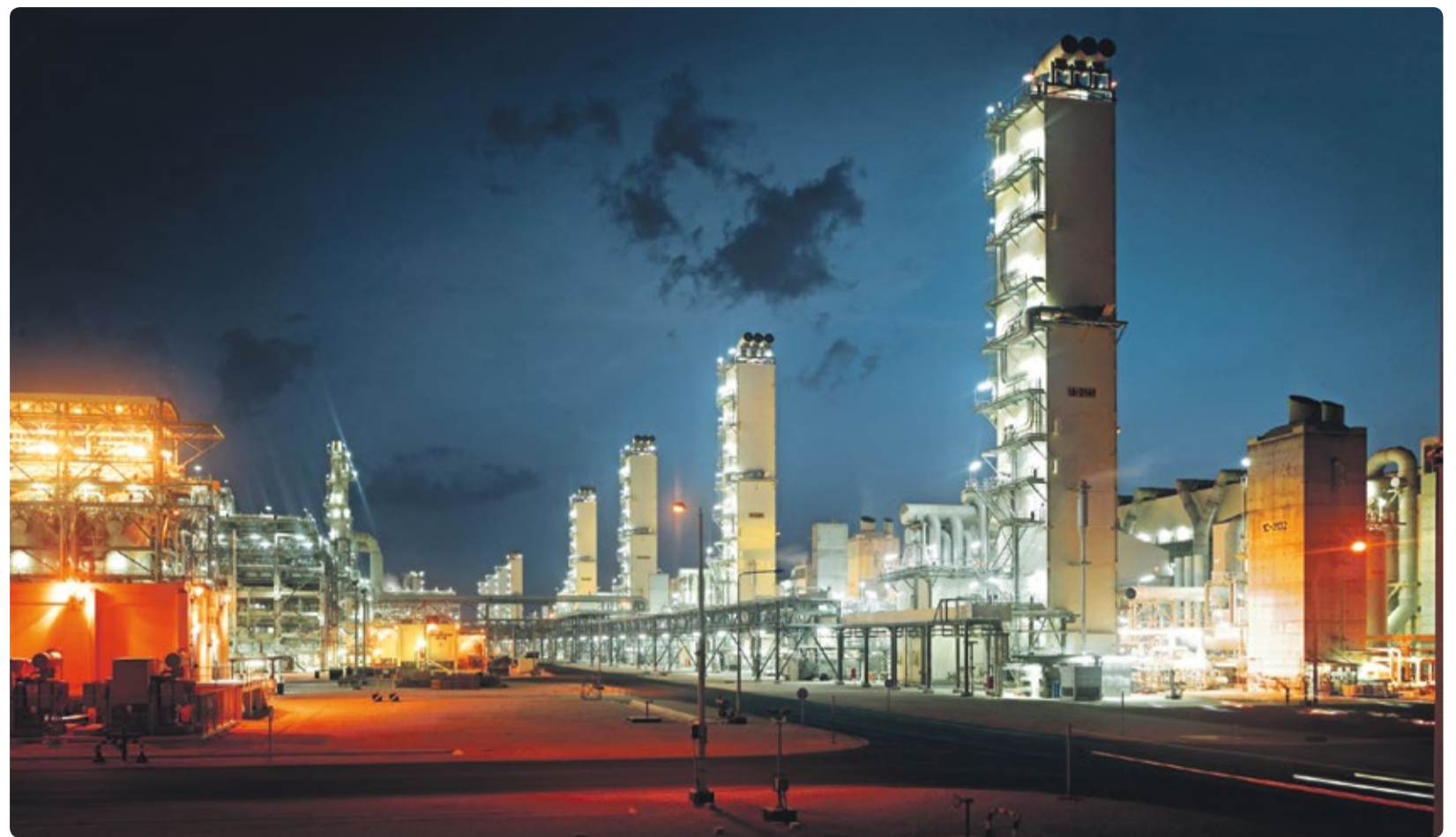
Die weltweit größte Gas-to-Liquids (GTL)-Anlage ging 2011 in Katar in Betrieb. Acht große, von Linde erbaute Luftzerlegungsanlagen versorgen die Anlage mit dem benötigten Sauerstoff – rund 860.000 Kubikmeter pro Stunde.
