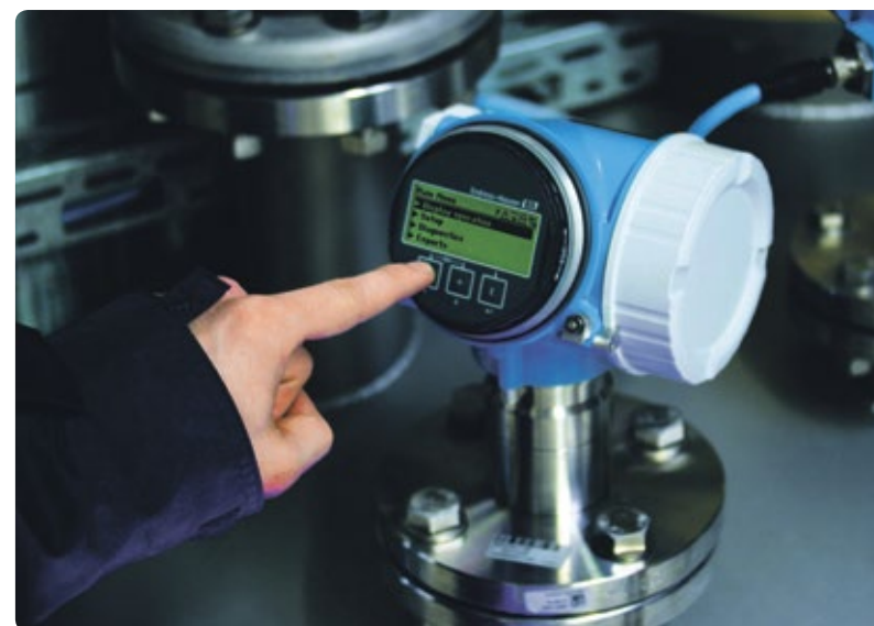
Integrierte Diagnose- und Prüfroutinen bestätigen die korrekte Gerätefunktion und erlauben eine Wiederholungsprüfung im eingebauten Zustand ohne Prozessunterbrechung mit hoher Prüftiefe.
