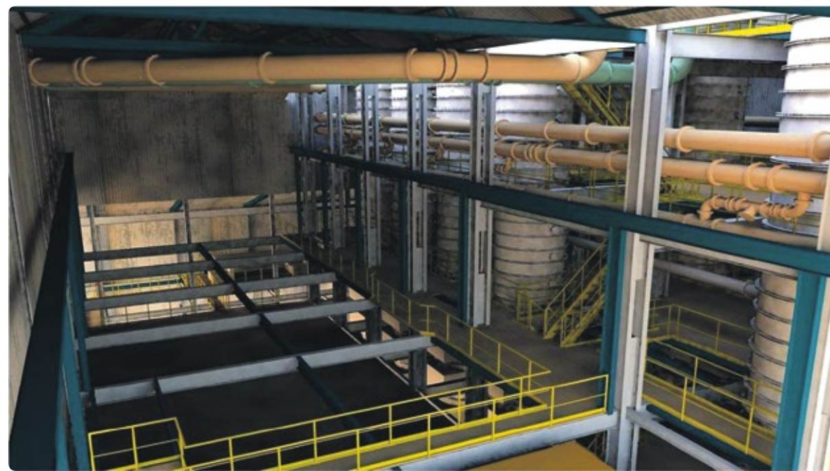
Redundante Rohrleitungen wurden im Modell farbcodiert, wodurch die allgemeine Last im Gebäude reduziert werden konnte.
