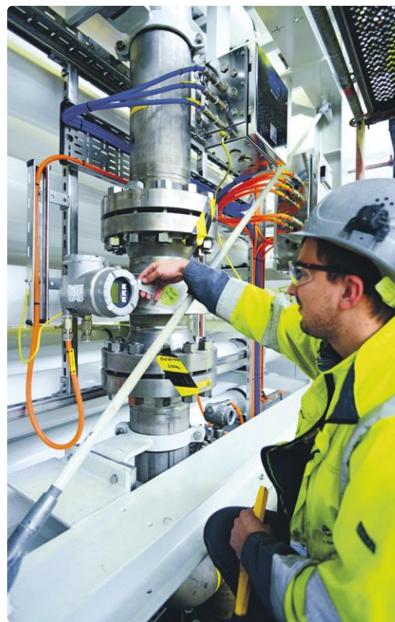
Abb. 1: Hart im Nehmen: Für den Einsatz auf hoher See hat Endress + Hauser magnetisch-induktive Durchflussmessgeräte aus hochreinem Titan gefertigt.
