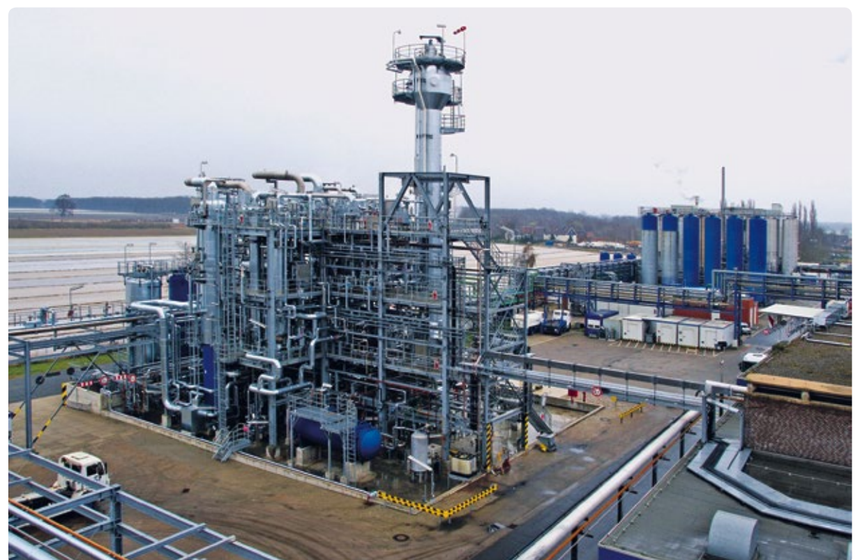
Abb. 1: Mit einem Anlagenmanagementtool wird die Anlagenplanung, wie die der Mineralölraffinerie Dollbergen / Avista Oil Refining & Trading, viel effizienter, überschaubarer und flexibler handhabbar.
