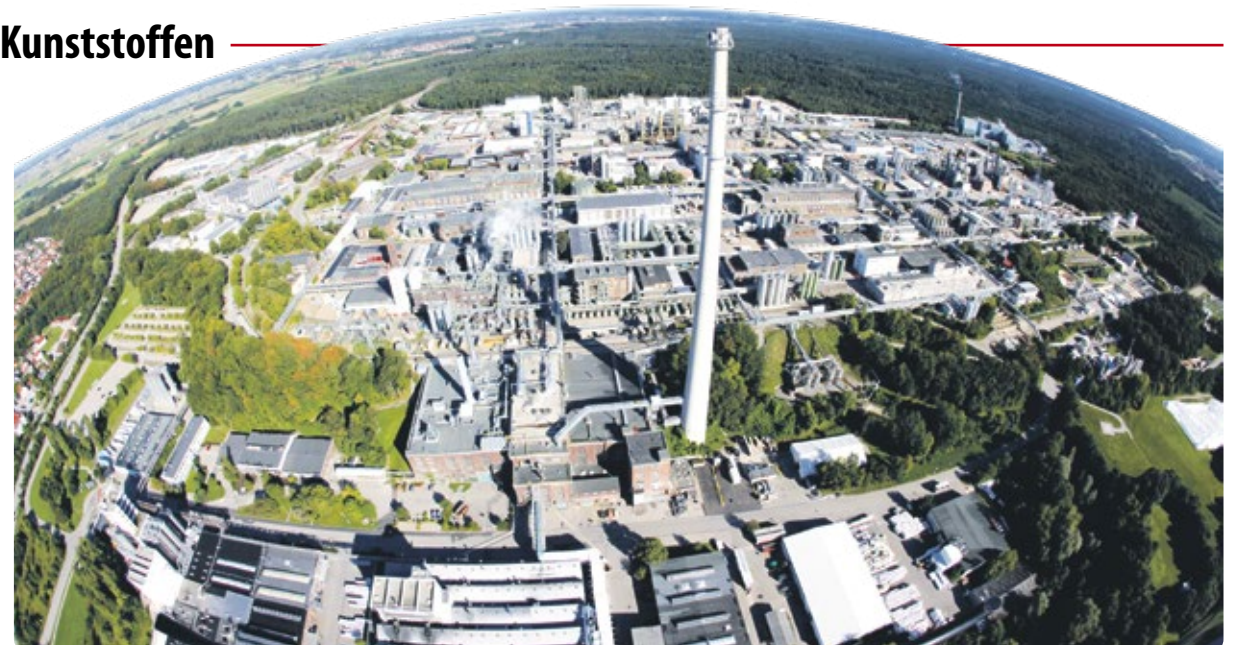
Im Industriepark Gendorf entsteht eine Hochtemperatur-Recycling-Anlage für Fluorpolymere, die im September 2014 in Betrieb gehen soll.
