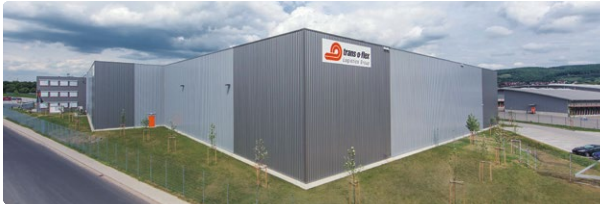
Speziell auf die Anforderungen der Pharma- und Gesundheitsindustrie zugeschnitten erfüllt das Logistikzentrum alle Standards der Good Manufacturing Practice (GMP) der Pharmabranche.
