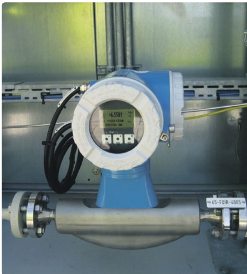
Abb. 2: Proline Promass ermöglichen eine kompakte Installation ohne Ein- und Auslaufstrecken; der direkt gemessene Gasmassstrom in kg/h macht eine zusätzliche Druck- und Temperaturkompensation unnötig.
