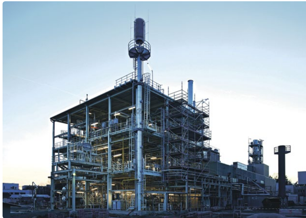
Die Bioliq-Pilotanlage am Campus Nord des Karlsruher Instituts für Technologie (KIT), an deren Bau CAC als Kooperationspartner beteiligt war.
