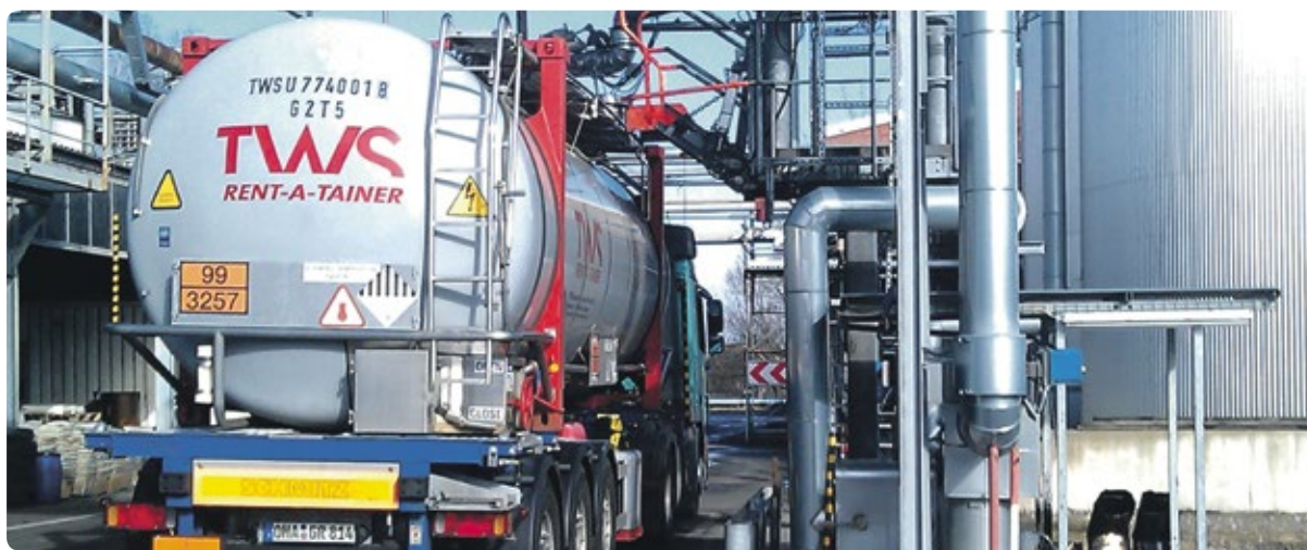
Container wird mit Bitumen beladen.
