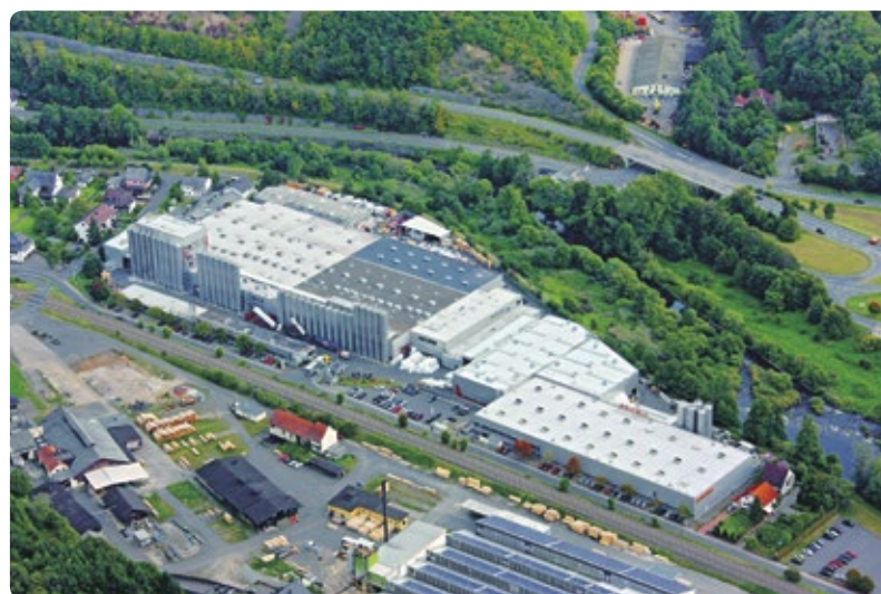
Die Kunststoffplattenproduktion von Simona findet im rheinland-pfälzischen Kirn im Werk 2 des Kunststoffverarbeiters statt.
