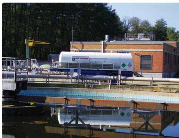
die Auswahl: So fassen mobile Tanks z. B. bis zu 30 t Sauerstoff in flüssiger Form, für sehr kurz dauernde Interimslösungen ist auch eine Ver-
