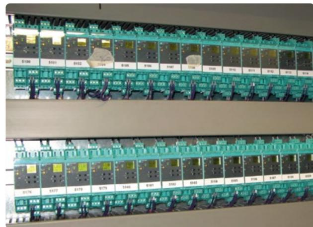
Abb. 2: Die Signalrenner gehören zum K-System von Pepperl + Fuchs und werden auf dem Power Rail montiert.
