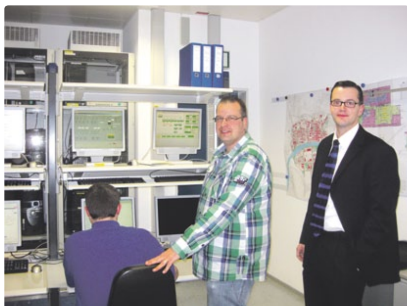
Christian Sturm (rechts) und Patrick Heiber in der Leitwarte der WFI-Anlage: „Die Migrations-Tools können dazu beitragen, den Programmieraufwand zu reduzieren.“
