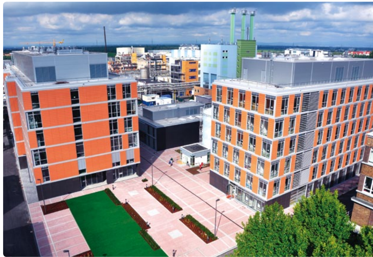
Bauen für die Wissensgesellschaft: Das neue Material Research Center von Merck in Darmstadt umfasst zwei Laborgebäude und ein Reinraumtechnikum (Mitte) und spiegelt die von Carpus + Partner geplante moderne Kommunikationsarchitektur wieder.
