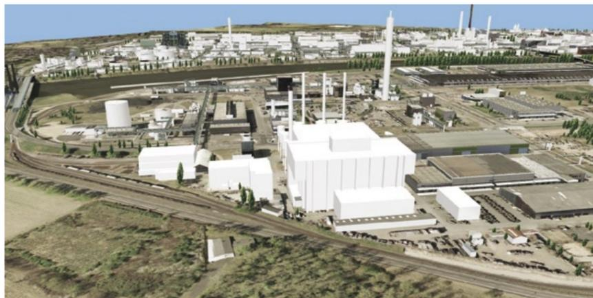
Für rund 300 Mio. € wird derzeit im Südwesten des Industrieparks Höchst eine Ersatzbrennstoffanlage zur Versorgung des Standortes mit Strom (70 MW) und Dampf (250 t/h). Sie soll 2009 in Betrieb genommen werden.
