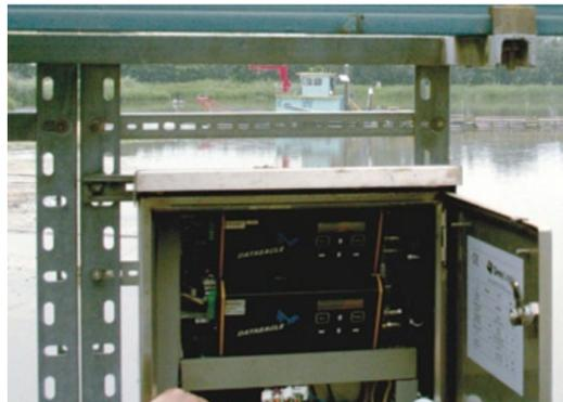
Abb. 2: Eine nachgerüstete, redundante Verbindung über Funkmodule, die ebenfalls mit 500 kbit/s arbeiten, erhöht die Anlagenverfügbarkeit.
