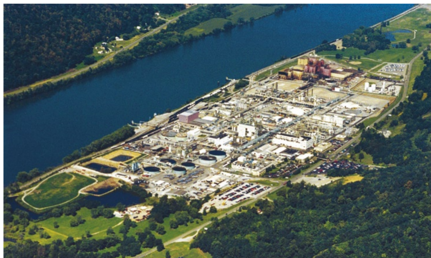
Der Bayer-Standort New Martinsville am Ohio River in West Virginia (USA) ist jetzt ein Industriepark, an dem weitere Produktionsbetriebe angesiedelt werden sollen. Der Standort wurde 1954 gegründet, das Gelände umfasst mehr als 40.000 m 2 (1.000 acres).
