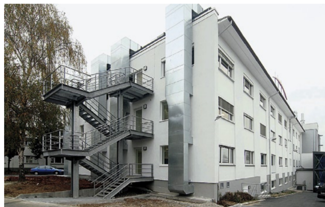
Abb. 1: Die Kapazitätserweiterung und die Optimierung der Personal- und Materialflüsse standen im Mittelpunkt eines Umbauprojektes in der Pharmaproduktion bei Stada in Bad Vilbel, für das Carpus + Partner als Generalübernehmer verantwortlich zeichnete.
