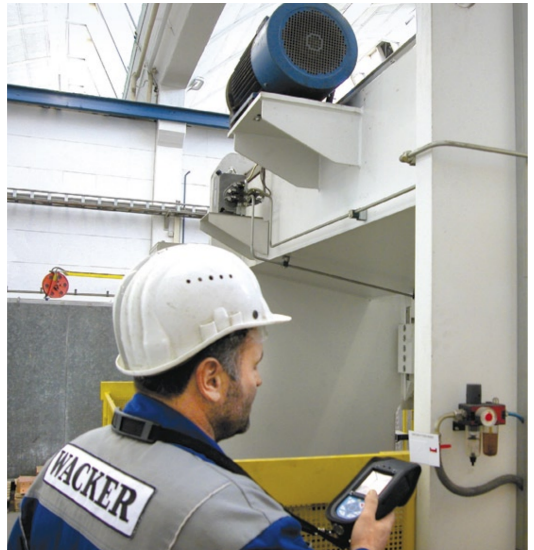
Ein Wacker-Mitarbeiter bei Wartungsarbeiten: Über einen RFID-Transponder erkennt der elektronische Assistent (ein ex-geschützter PDA) die zu wartende Anlage und zeigt an, welche Wartungsmaßnahmen durchzuführen sind. Das Gerät dient auch der Erfassung der durchgeführten Arbeiten. (Foto: Wacker Chemie)
