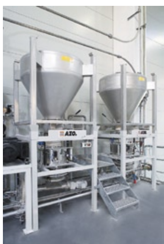
Abb. 4: Aufgabestation für Wechselcontainer
