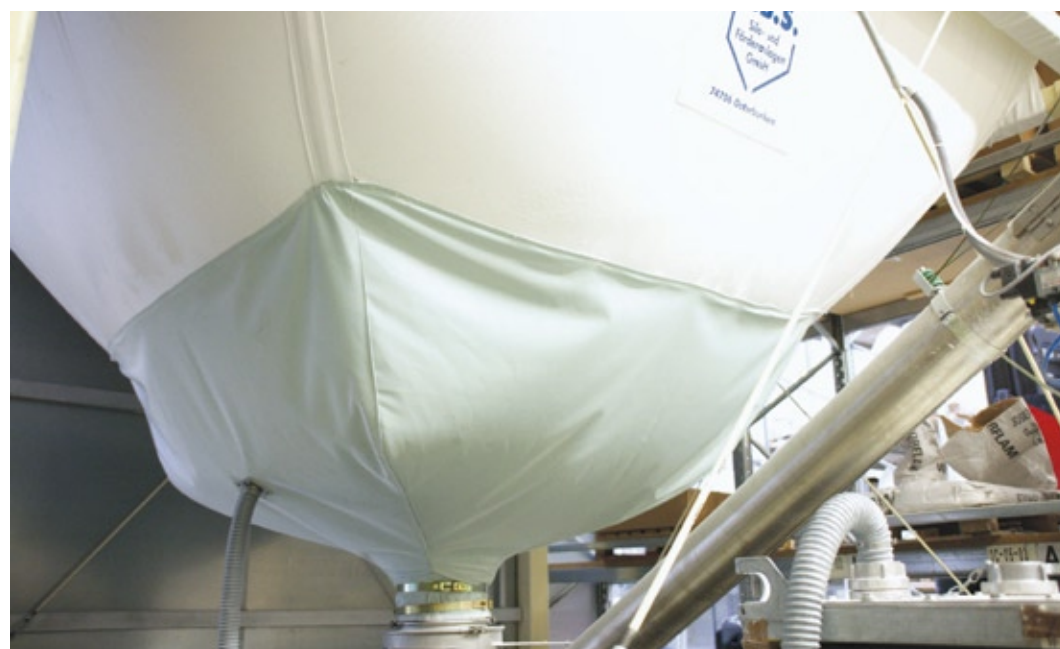
Abb. 3: Im Konus des Silos sichert die Austragshilfe „Fluid-Ex“, über die Luft zur Auflockerung in das feinpulvrige Lagergut geblasen werden kann, einen problemlosen Auslauf.
