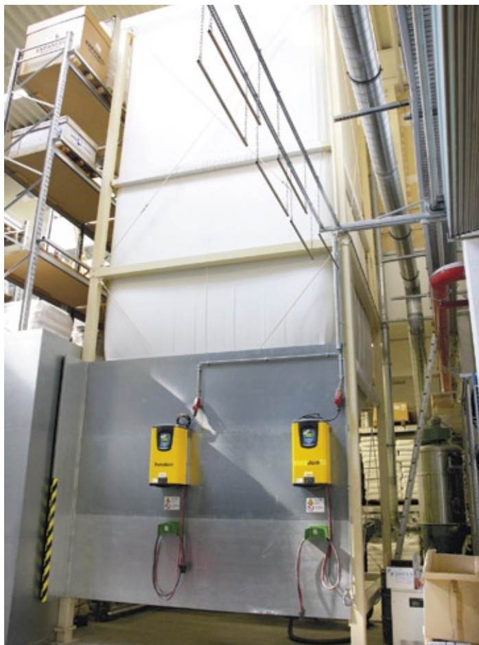
Abb. 1: Das schlanke und hohe A.B.S.-Flexsilo aus staubdichtem und antistatischem Gewebe konnte schnell und ohne Fundament errichtet werden, der vorhandene Raum wird optimal genutzt. (Fotos: Klaus Vollrath)
