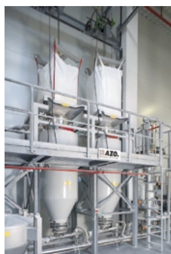
Abb. 3: Big-Bag-Entleerung in Pufferbehälter
