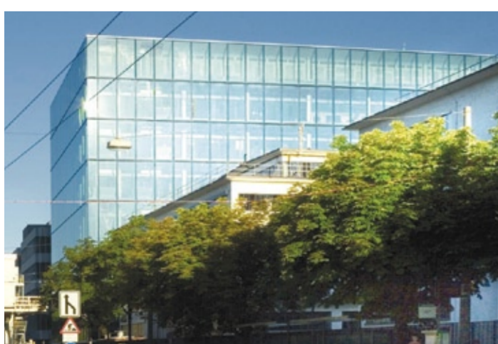
Außenansicht auf die Glasfassade des neuen Biotech-Zentrums von der Grenzacher Straße gesehen.
