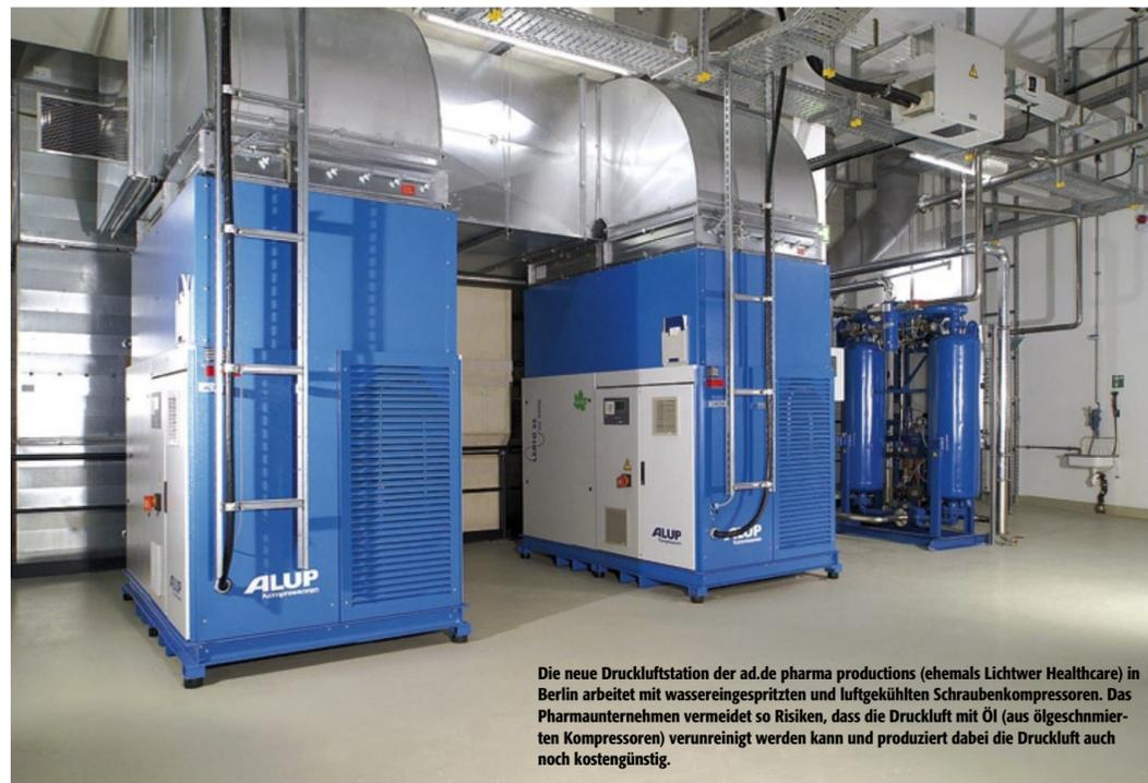
Die neue Druckluftstation der ad.de pharma productions (ehemals Lichtwer Healthcare) in Berlin arbeitet mit wassereingespritzten und luftgekühlten Schraubenkompressoren. Das Pharmaunternehmen vermeidet so Risiken, dass die Druckluft mit Öl (aus ölgeschmierten Kompressoren) verunreinigt werden kann und produziert dabei die Druckluft auch noch kostengünstig.
