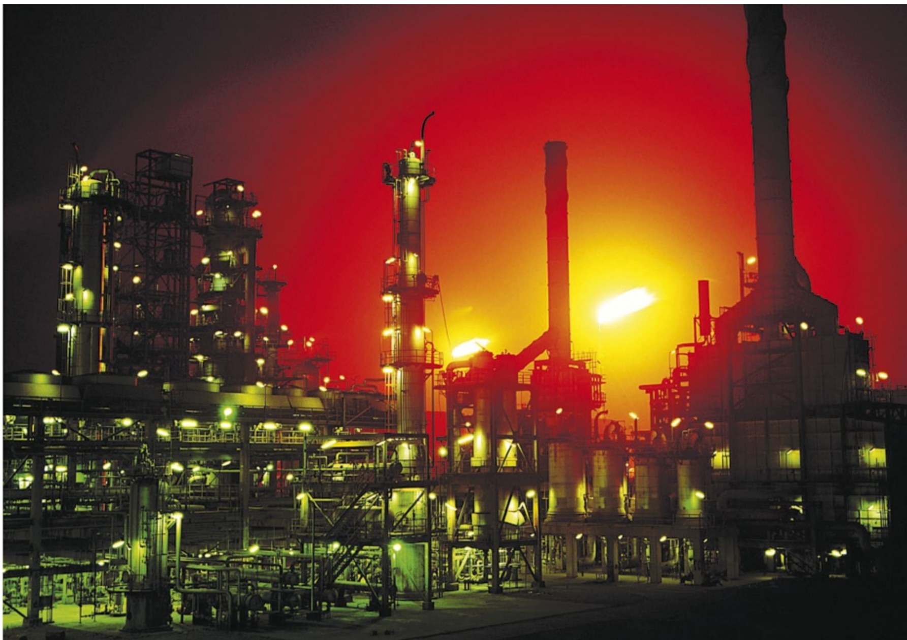
Abb. 1: Sicherheit ist in chemischen Anlagen wichtig. Verfahrenstechnische Komponenten online zu testen ist eine Möglichkeit Sicherheitsanforderungen mit betrieblichen Anforderungen zu vereinbaren.
