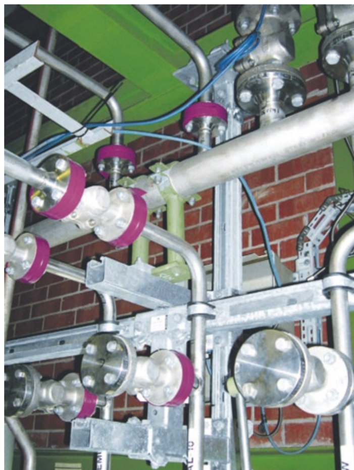
Abb. 2: Das Träger- bzw. Unterstützungssystem von Halfen-Deha erlaubt komplexe Konstruktionen, obwohl es nur aus wenigen Bauteilen besteht – weil die Bauteile multifunktional und stufenlos justierbar sind.
