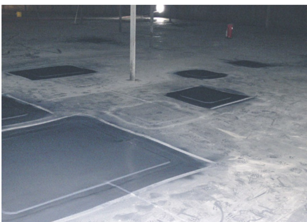
Nachdem der Tank gereinigt ist, lassen sich eventuelle Schäden an der vorhandenen Bodenbeschichtung feststellen. Die können dann – wie hier im Bild – mit einer neuen Teilinnenbeschichtung ausgebessert werden. (Foto: Thyssenkrupp Xervon)
