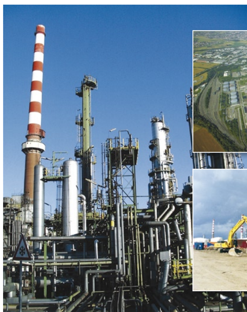
Ab 2007 begann Arcadis mit der Erkundung des Standorts Ingolstadt der Bayernoil Raffineriegesellschaft. Die Demontage der Prozessanlagen und der bis zu 115.000 m 3 fassenden Stahl tanks stellt eine besondere Herausforderung dar.
