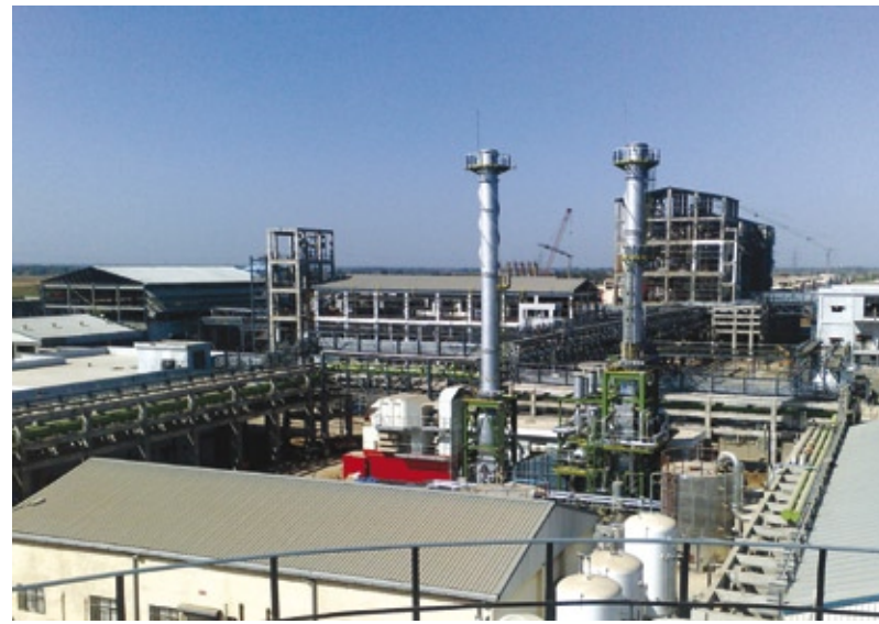
Baustelle Jhagadia: Im Bundesstaat Gujarat entsteht der größte Produktionsstandort für Lanxess in Indien. Triplan ist zusammen mit seinem Kooperationspartner Neilsoft als Gesamtplaner für die Verlagerung der Produktion von Madurai nach Jhagadia beauftragt. © Lanxess.
