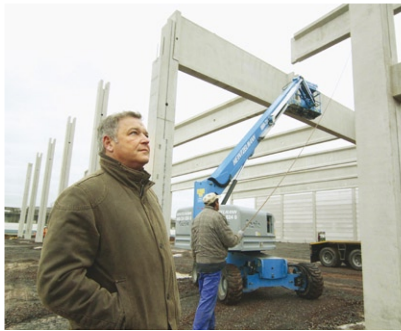
Logistikzentrum in Fußgönheim: Bauherr Peter Norheimer, Geschäftsführer der Frigo-Trans, inspiziert die Baufortschritte.
