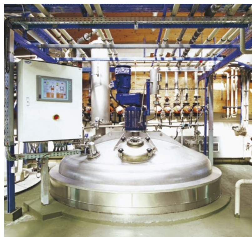
Neue Mischanlage am Brenntag-Standort in Duisburg
