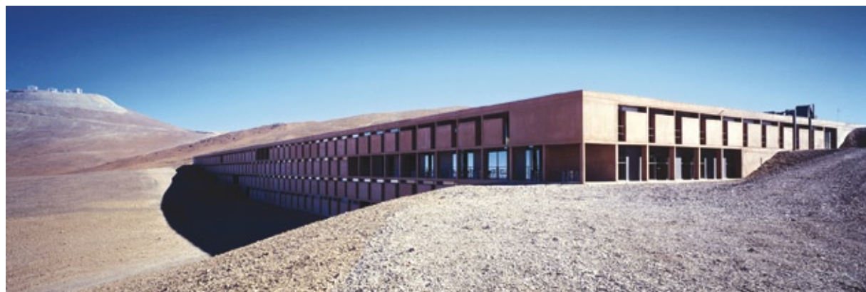
Das ESO-Hotel im chilenischen Cerro Paranal fügt sich mit seiner rotbraunen Farbgebung sanft in die Wüste ein. Farbgebend sind hier Bayferrox-Pigmente von Lanxess.
