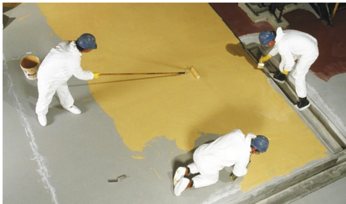
Ein gängiges Verfahren ist es heute, Böden mit Epoxidharz zu beschichten.
