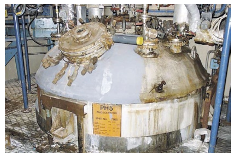
Unwirtliche Umgebungsbedingungen: Phosgenierungsreaktor
