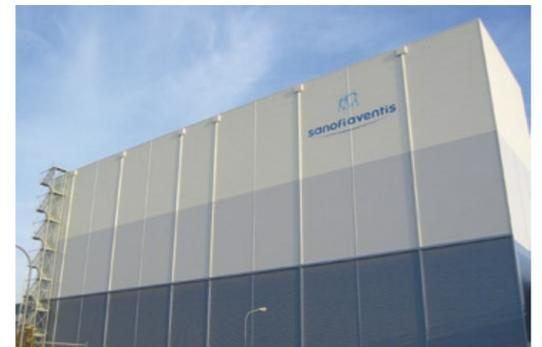
Bauzeit von nur 16 Monaten. 70.000 Trägereile wurden dafür mit 280.000 Schrauben verbunden, nahezu 10 Kilometer Sprinklerleitungen verlegt, 6.700 Sprinklerköpfe montiert und Lüftungsgeräte eingebaut, die 160.000 Kubikmeter Luft pro Stunde umwälzen und dafür sorgen, dass der Temperaturunterschied zwischen oben und unten weniger als zwei Grad Celsius beträgt. Eine besondere Herausforderung war es, die 27 Tonnen schweren Re-
