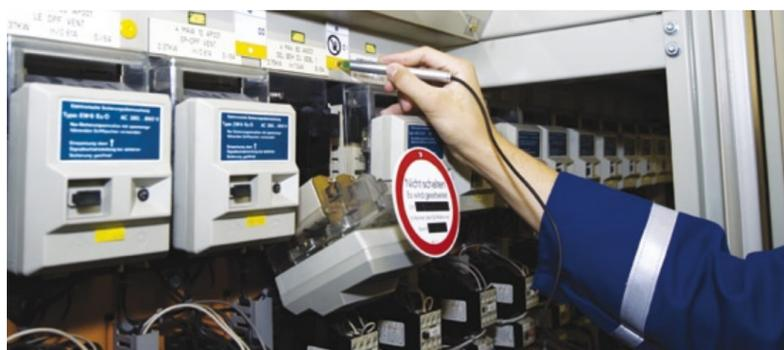
Einsatz der V-RFID-Chips von Evonik Energy Services zur Anzeige des Freischaltzustands
