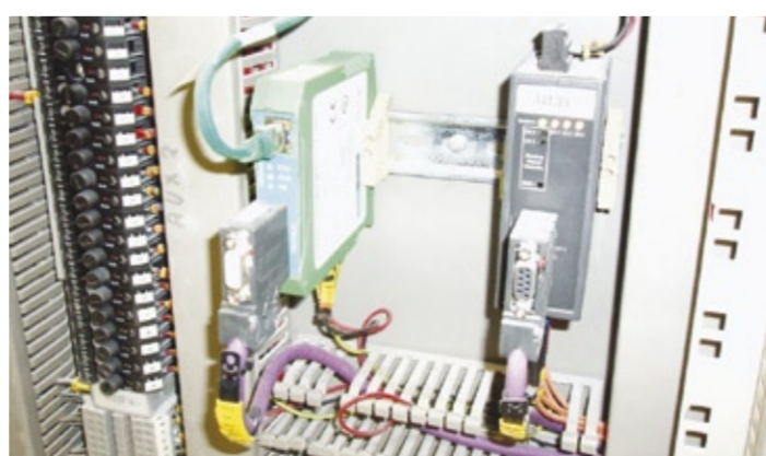
Abb. 3: Das Ethernet-Profibus-Interface (EPI) (grünes Bauteil) ermöglicht die einfache Anbindung von Profibus-Netzen an das Ethernet. Es unterstützt eine umfangreiche Anzahl von internationalen offenen Standards auf einer Hardwareplattform. Dazu gehören FDT, EDD, OPC und Profinet. Mit dem Gateway können herstellern unabhängige Lösungen und flexible Konzepte zur durchgängigen vertikalen Integration von Produktionsprozessen realisiert werden.
