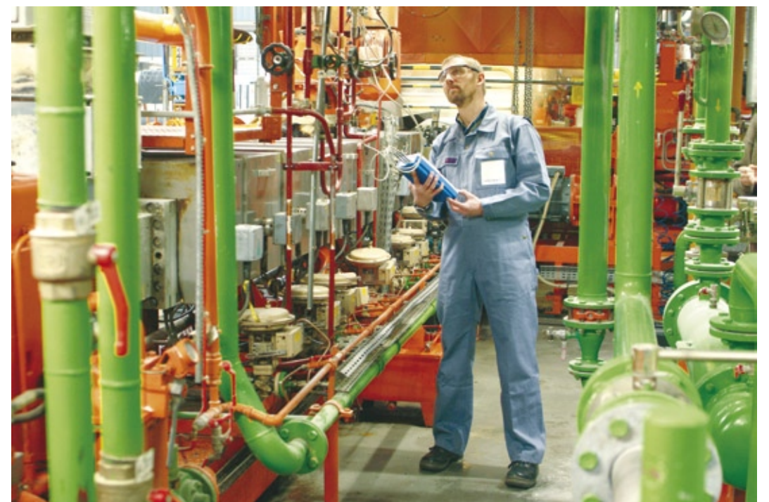
Abb.1: Qualifizierte Kalibriertechnik von Endress + Hauser kalibriert mit akkreditierten Kalibratoren. Zudem verfügt der Hersteller mit Fieldcheck als einziger Anbieter über einen Prüf- und Verifikationstool, das Durchflussmessgeräte im eingebauten Zustand ohne Prozessunterbrechung kontrollieren kann.
