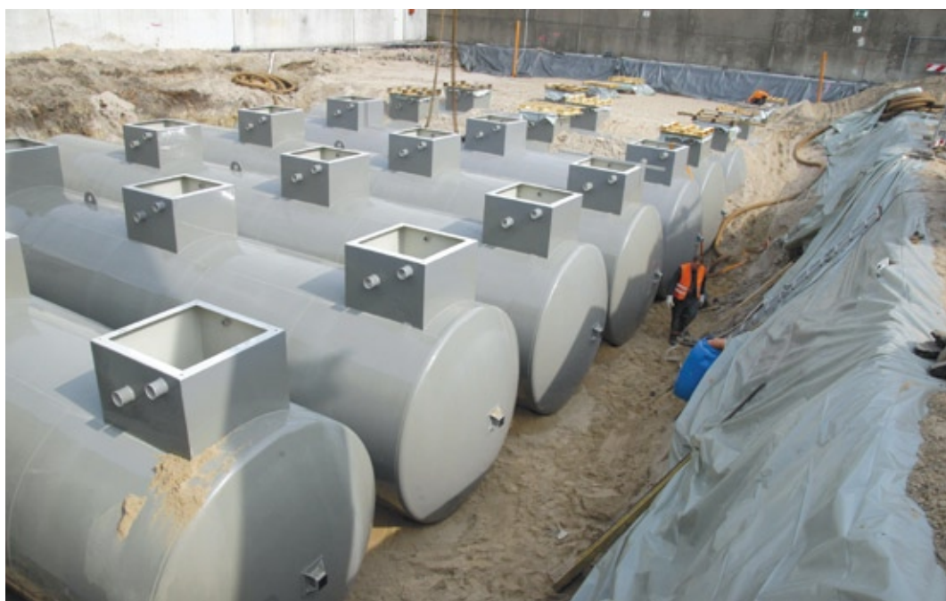
Bau des Tank- und Fassregallagers: Die neuen Lösungsmittel tanks liegen in Position
